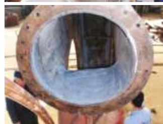
Beschichtung eines Pumpengehäuses
