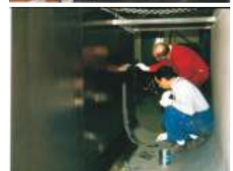
Beschichtung eines Mischbeckens
