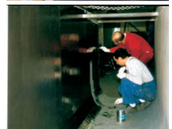
Beschichtung eines Mischbeckens
