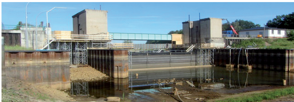
Bild 1 Wehranlage Quitzöbel während der Sanierungsmaßnahme
